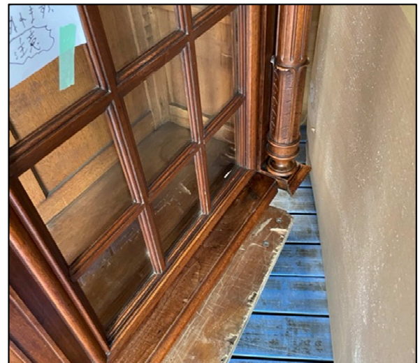
開閉の金具が足りない
