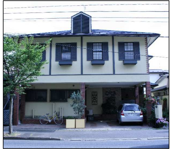
Before 吹き付け塗装
